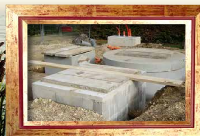
La station de pompage située sur l'ancien site
