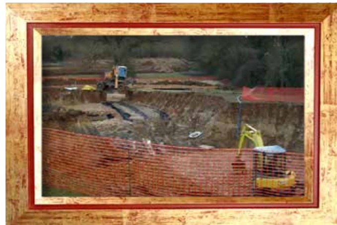
Puis vinrent des machines
