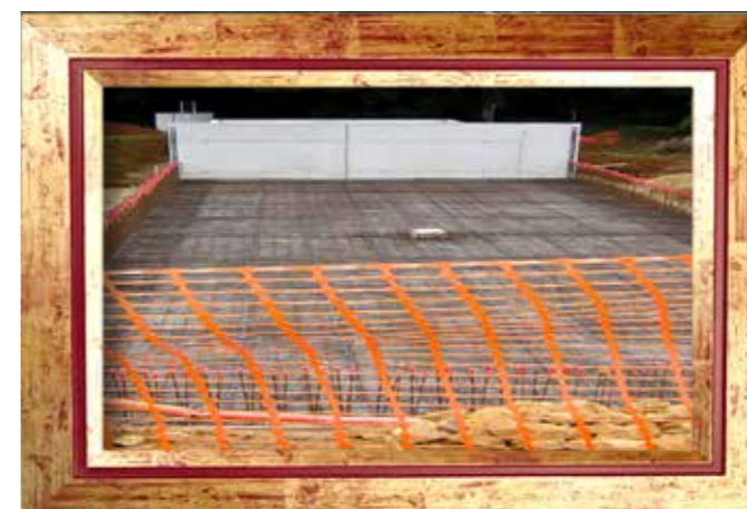
Le raccordement de l'ancienne station à la nouvelle est prévu en février 2011
