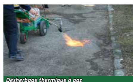
Désherbage thermique à gaz
