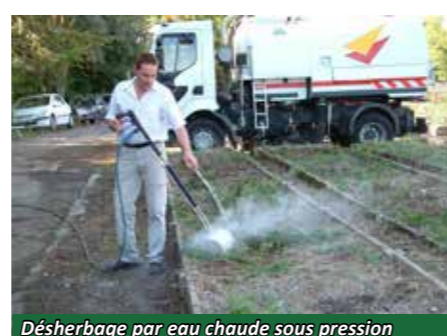
Désherbage par eau chaude sous pression
