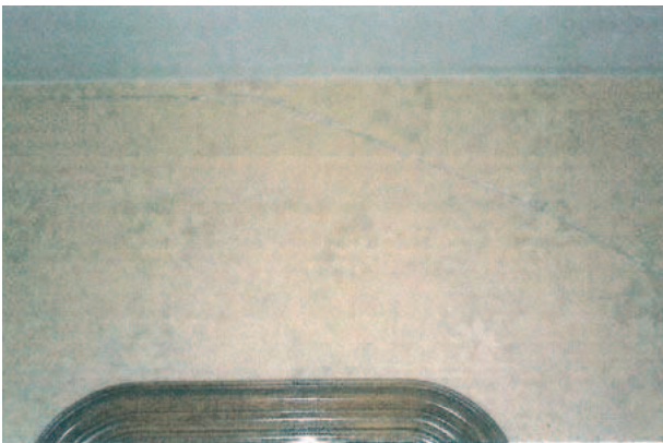
Fissuration intérieure, tapisserie déchirée - Maison André.
